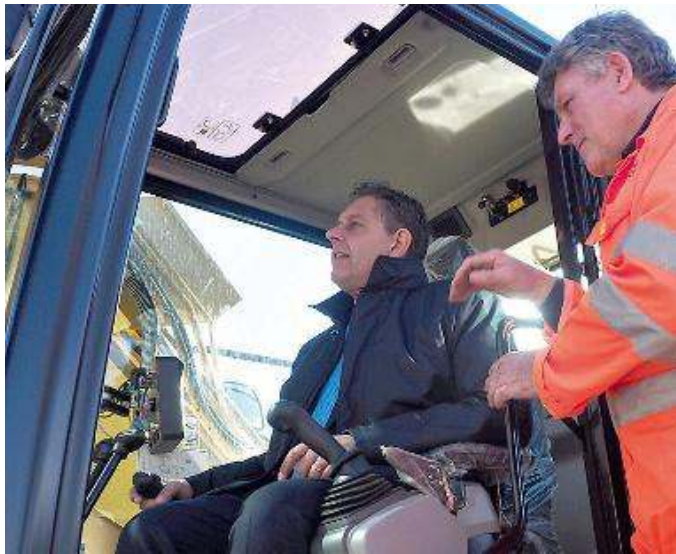
L'abbattimento dell'edificio per cominciare la costruzione dell'argine. Il presidente della Regione Toti alla guida della ruspa
